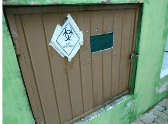
Foto 52 – Espaço identificado, destinado ao armazenamento de RSS do Grupo A (infectantes) no Hospital Municipal Santana. Notar tela de proteção contra roedores e vetores, conforme determina a Resolução RDC Anvisa nº 222/2018.
