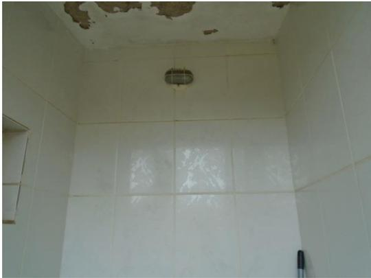
Foto 55 – Interior da Central de Armazenamento de Resíduos na Unidade de Saúde de proteção integral da mulher e da criança, Guilhermina da Luz Ferreira, com ponto de iluminação, conforme determina a Resolução RDC Anvisa nº 222/2018.
