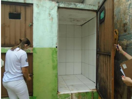
Foto 51 – Central de armazenamento de RSS no Hospital Municipal Santana. Local de acesso restrito e construído com piso e paredes de material resistente, lavável e de fácil higienização, conforme determina a Resolução RDC Anvisa nº 222/2018.
