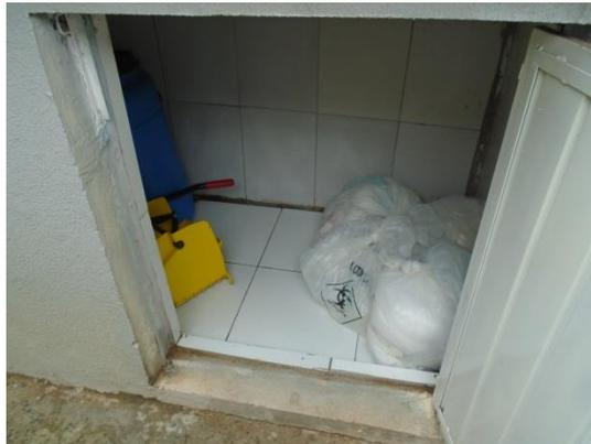
Foto 57 – Interior da Central de Armazenamento de RSS na Unidade de Saúde da Família, Bento José da Costa, porta com abertura para fora, conforme determina a Resolução RDC Anvisa nº 222/2018.
