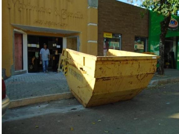
Foto 36 – Caçamba utilizada para o armazenamento de RCC.
