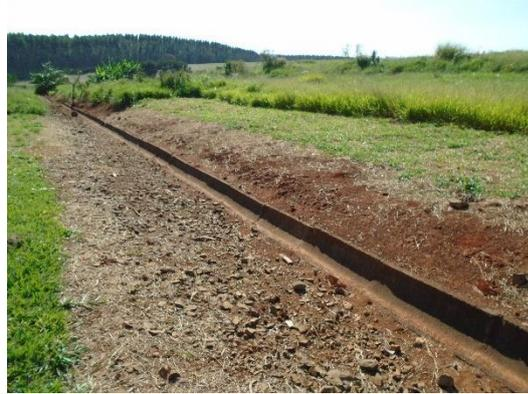
Foto 17 – Estrutura para drenagem de águas pluviais (canaleta).
