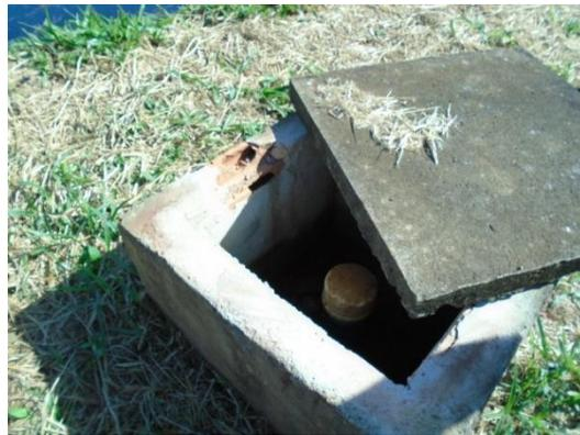
Foto 19 – Poço de monitoramento desativado no interior do Aterro Sanitário.
