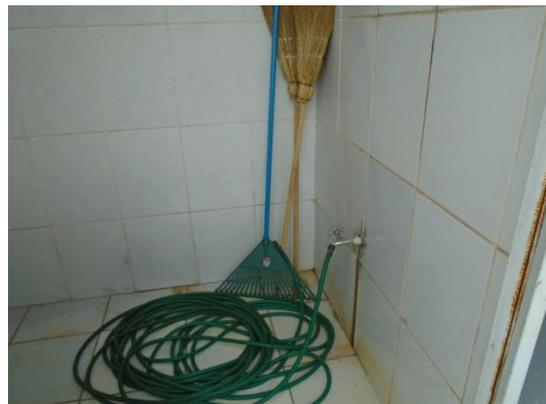
Foto 54 – Interior da Central de Armazenamento de Resíduos na Unidade de Saúde de proteção integral da mulher e da criança, Guilhermina da Luz Ferreira, com ponto de saída de água para higienização e limpeza dos coletores utilizados e dotada de ralo, conforme determina a Resolução RDC Anvisa nº 222/2018.
