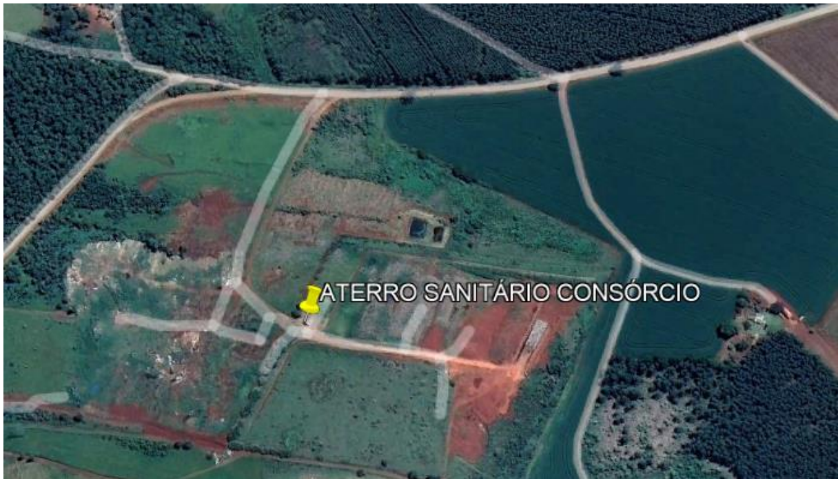
Figura 28 – Localização do Aterro Sanitário em Consórcio
