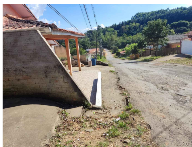
MURO PARCIAL -À DEMOLIR
