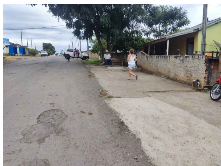
CALÇADA À DEMOLIR -À DEMOLIR
